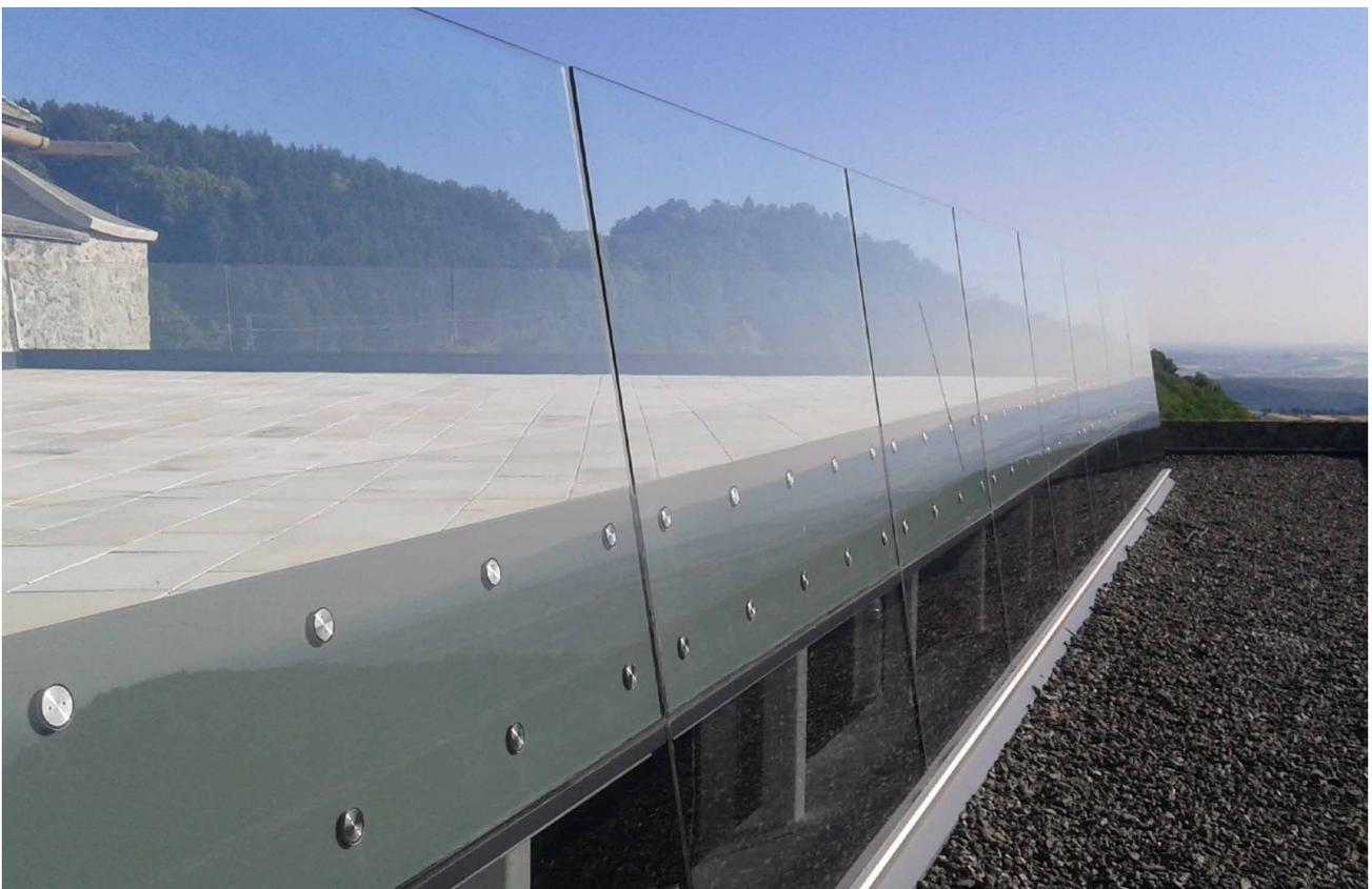
Dieses Projekt zeigt ein Glasgeländer mit eingespanntem Glas. Das Glas wurde mit flächenbündigen Punkthaltern montiert. Im Bereich der Punkthalter ist das Glas emailliert um die Konstruktion darunter zu verdecken.
