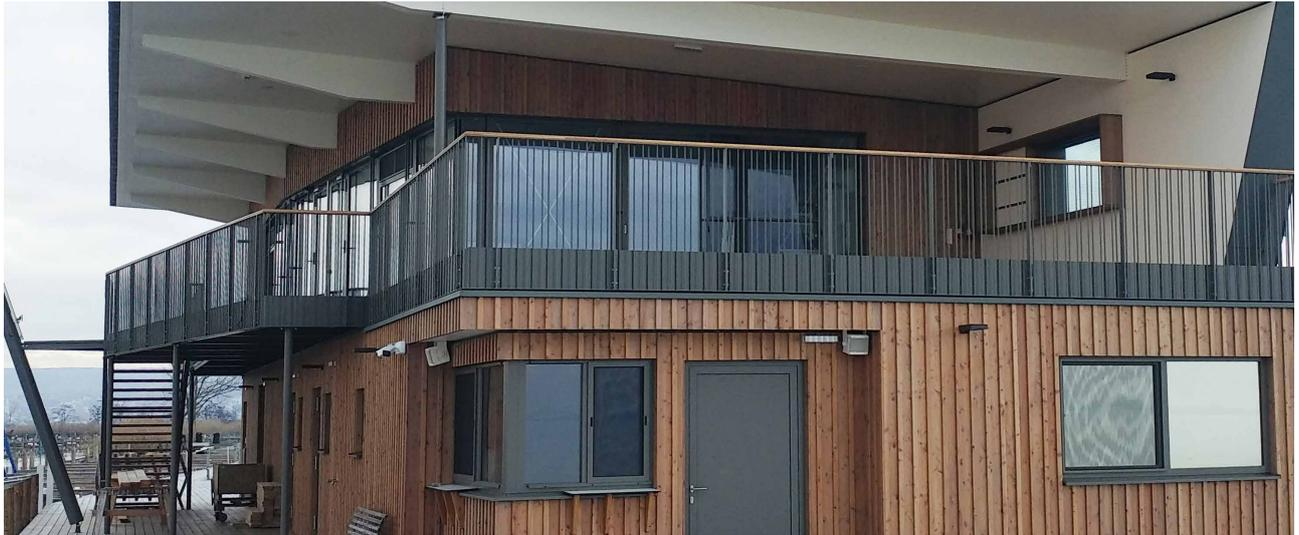
Das hier gezeigte Projekt liegt an einem See mit erhöhtem Salzgehalt. Aus diesem Grund wurde eine dickere Zinkschicht, sowie eine Pulverbeschichtung aufgetragen.
