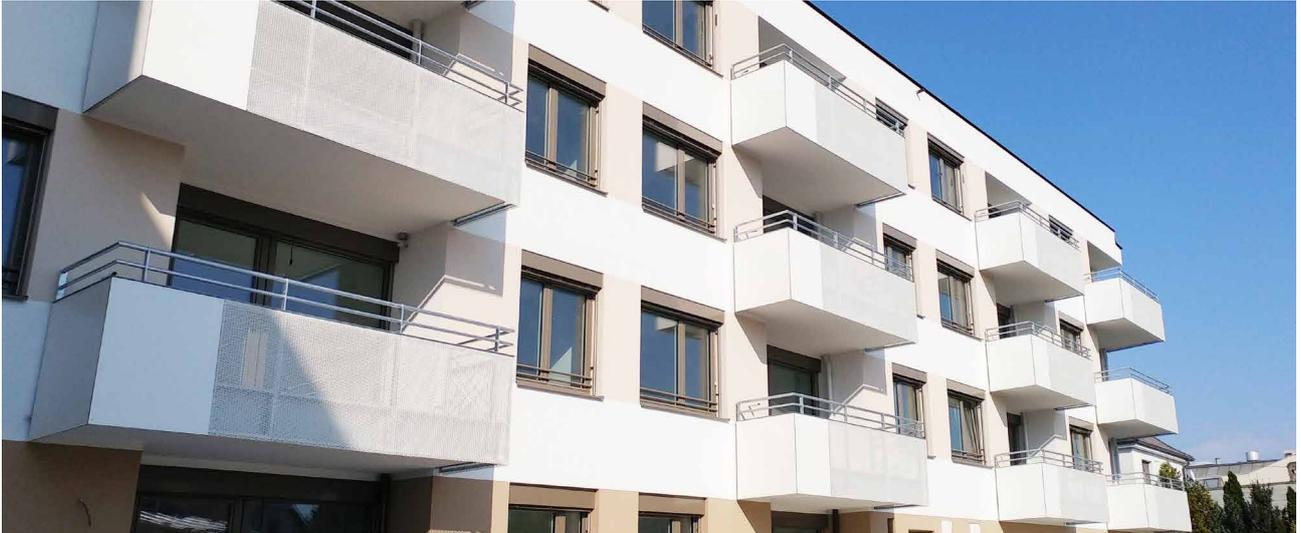
Bei dem hier gezeigten Projekt, wurden Formrohrrahmen mit Wangenblech seitlich an die Balkonplatte montiert. Zusätzlich wurden im oberen Bereich horizontale Durchzüge gesetzt. Die Durchzüge dienen zur Auflockerung der Konstruktion, dadurch entsteht eine Kombination aus flächiger Füllung und Stabfüllung.
